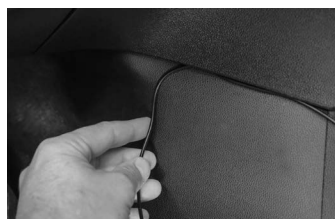
Fig. 5 : pose du câble
