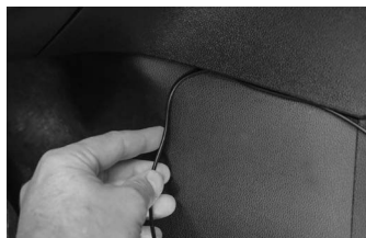
Figura 5: Posare i cavi
